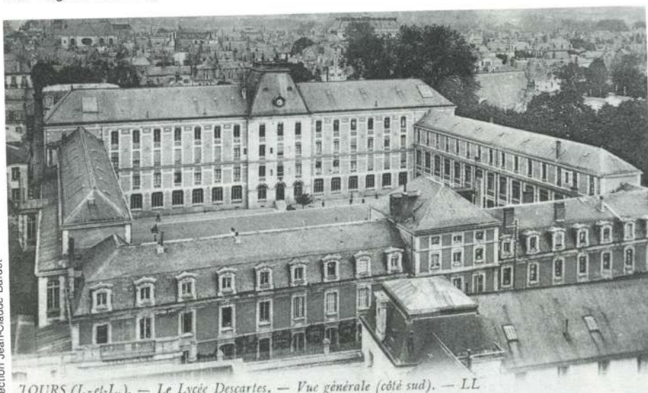
TOURS (I.-et-L.). — Le Lycée Descartes. — Vue générale (côté sud). — LL.
